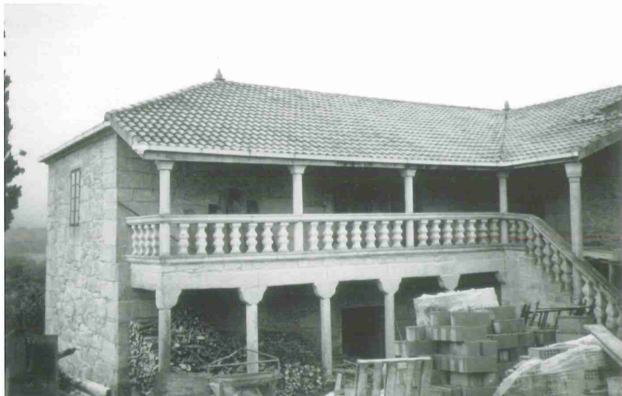
Vista del pazo durante las obras de restauración
