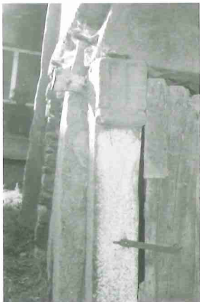
Elementos da antiga fábrica
