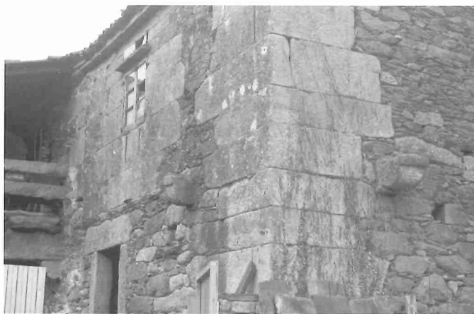
Restos de estruturas desaparecidas
