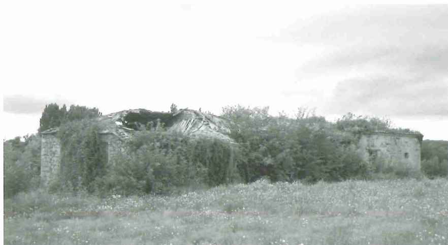
Imaxe xeral do pazo en ruínas antes da súa limpeza
