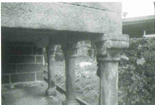
As columnas ornamentadas que sustentan o corredor
