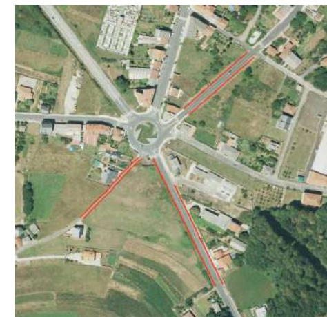
Imaxe 161. Actuación tramo da Rolda Leste (Fonte: Elaboración Propia e datos publicados en xornais )
