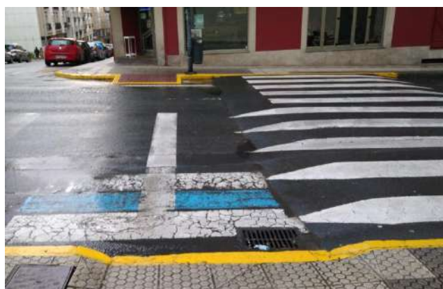
Imaxe 138. Paso de peón sen con sinalización horizontal contradictoria na rúa B (Fonte: Elaboración propia)
