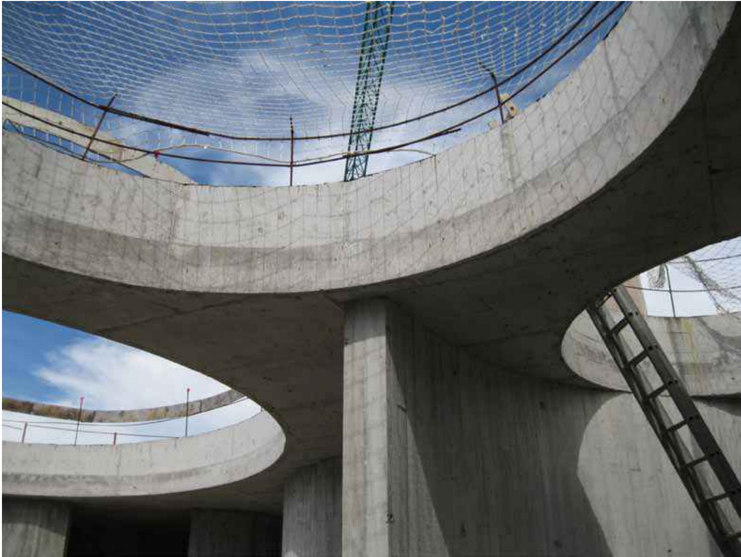
Cuberta da torre do Concello
