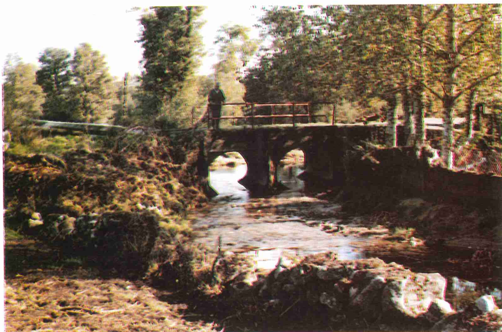
O novo pontilón de Casar de Seta, construído sen ter en conta as características do cauce nin as da conca, serviu de muro de contención á riada, ocasionando danos na vivenda próxima por inundación.
